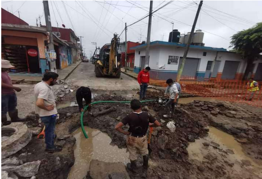
Reparación de fuga de agua en redes de distribución general
