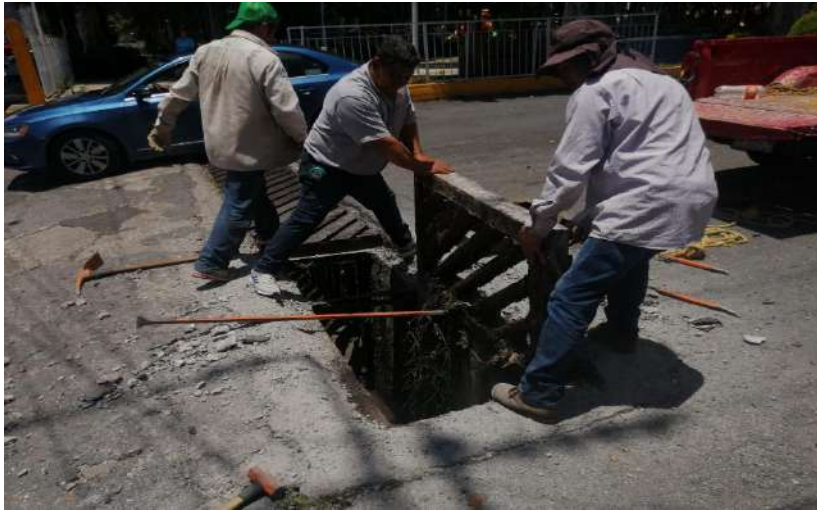
Desazolve en Alcantarillas.
