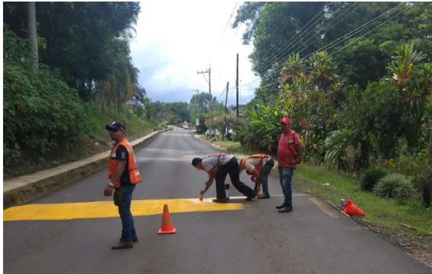
Balizamiento de topes.
