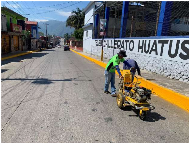
Limpia y pintado de banquetas y guarniciones.
