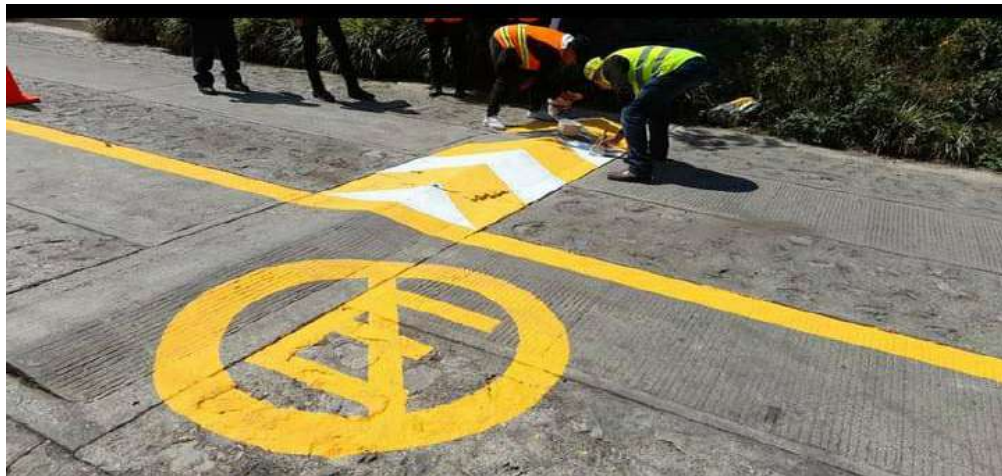
Marcando cruces peatonales. banquetas y reducciones de velocidad.
