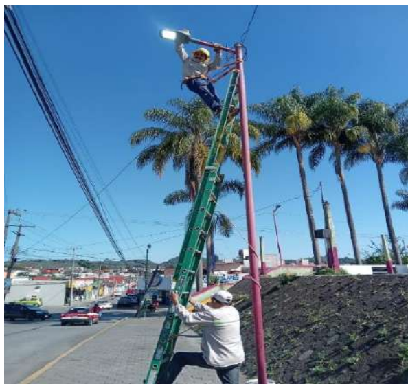
Instalando Luminarias en la Ciudad de Huatusco.
